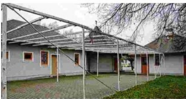
Statt eines Zelts wird zukünftig hier das neue Veranstaltungszentrum stehen. (VVA)
